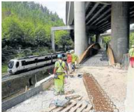
Operarios trabajan junto a la pasarela instalada bajo la autopista.
